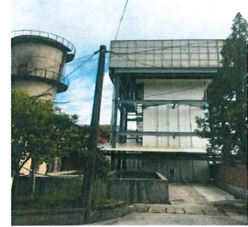
老南风井喷淋除尘系统
