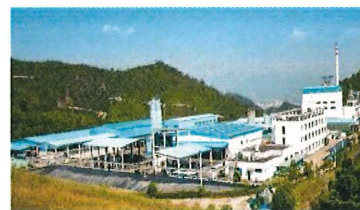
东江环保承建广东省危险废弃物综合处理中心
