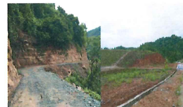
尾矿库清污分流工程道路疏通 尾矿库分流渠工程
