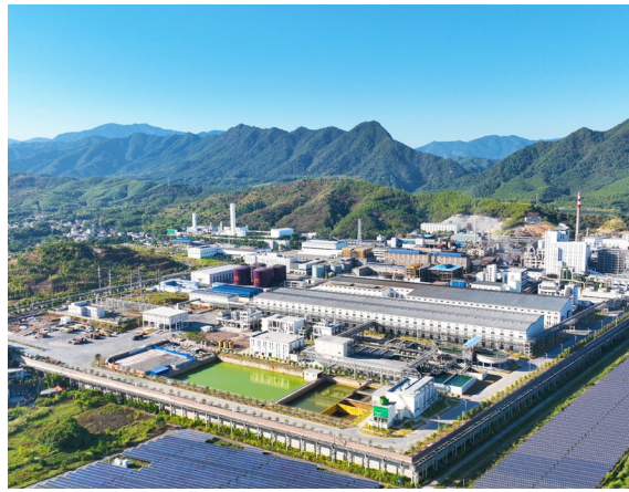
丹霞冶炼厂炼锌渣绿色化升级改造项目
